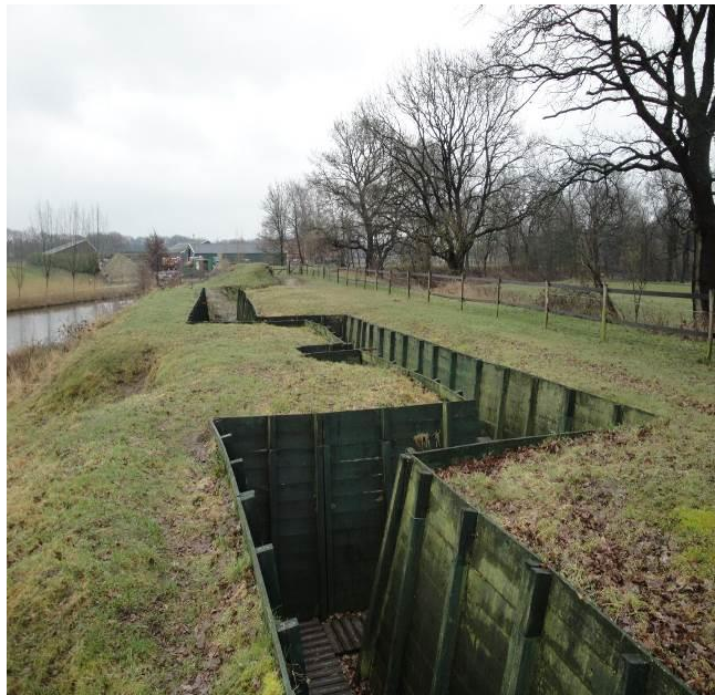
Gereconstrueerde loopgraaf in Scherpenzeel
